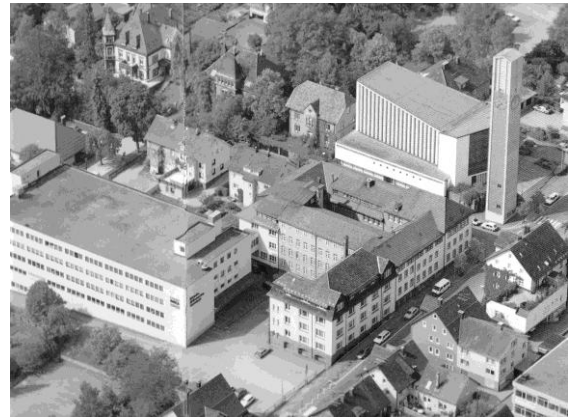
MB-Firmengelände, heutige Ansicht
